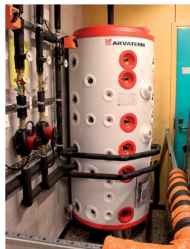
Для накопления тепла используется 500-литровая емкость.
