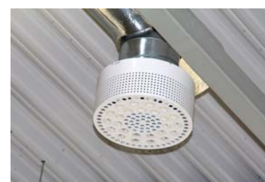
Потолочное воздухоораспределительное устройство Climescop обеспечивает равномерную подачу высококачественного приточного воздуха
