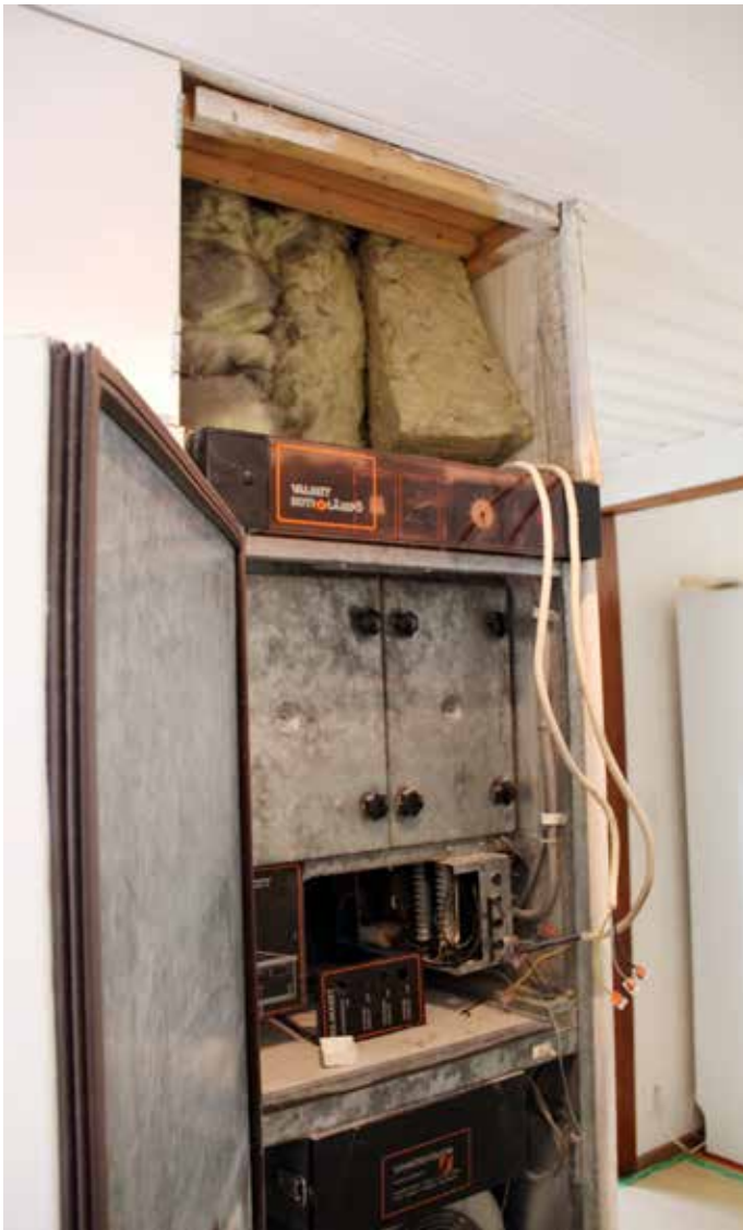
Vanha Kotilämpö ennen purkua.
