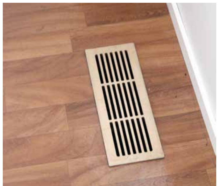
Sokkelissa tai talon rakenteissa kulkevista ilmakehista lämmin ilma siirtyy huoneeseen lattia rajassa sijaitsevien ilmaritilöiden kautta.
